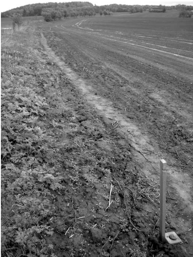
Geodetické vytučení cesty v poli, některé úseky byly zcela zničeny, rozorány, čekají na zcela nové založení
