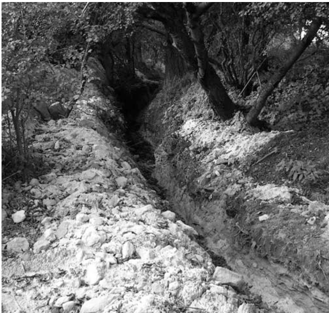
Výkop pro pokládku kabelů ČEZ, od června dodnes nezasypán
